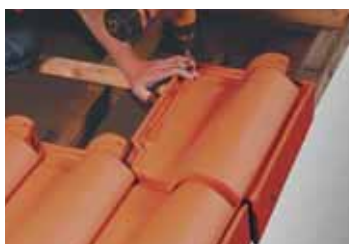
Fixation des tuiles en rive latérale droite par vis et rondelle d'étanchéité.
