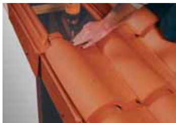
Fixation des tuiles double bourrelet en rive latérale gauche par vis et rondelle d'étanchéité.
